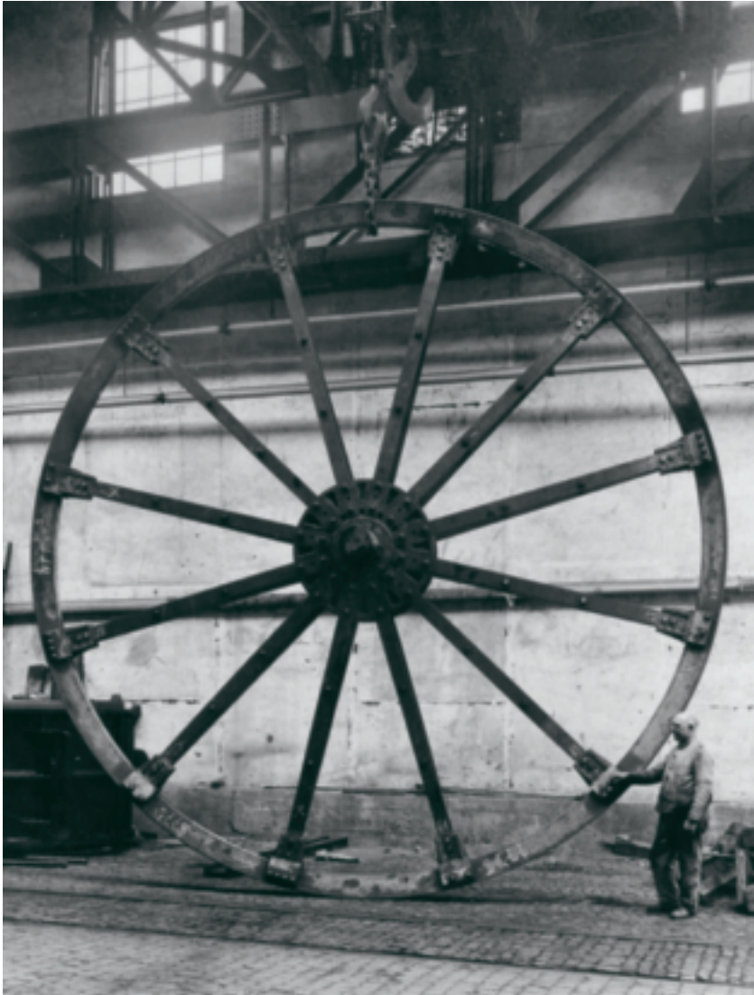
Volles Programm: Zum Portfolio der 1916 übernommenen Siegener Maschinenbau-Aktiengesellschaft vormals A. & H. Oechelhäuser gehören unter anderem gewaltige Seilscheiben, die in Förderanlagen des Bergbaus zum Einsatz kommen.
